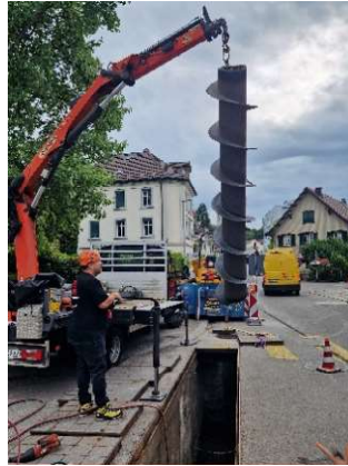
Abbildung 45: Ausbau Archimedes Schnecke
