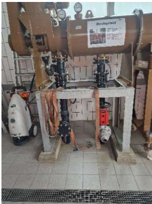
Abbildung 1: Alte Schlammsiebung
