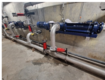
Abbildung 5: Neue Frischschlammumpen
