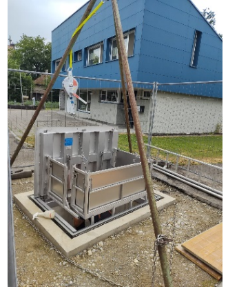
Abbildung 51: Einstieg Pumpensumpf neu
