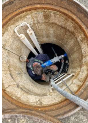
Abbildung 50: Einstieg Pumpensumpf alt
