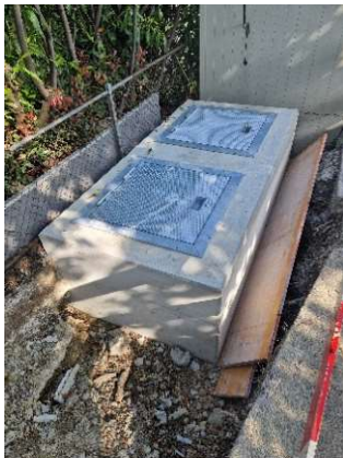
Abbildung 47: Neuer Pumpenschacht im Pärkli
