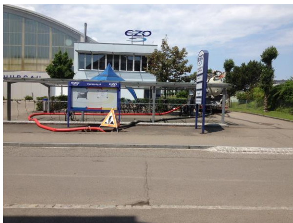
Abbildung 3: Entleeren des überfluteten Pumpwerks Egnacherweg
