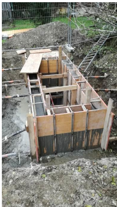
Abbildung 10: Schalung neuer Einstieg RB Verzinkerei
