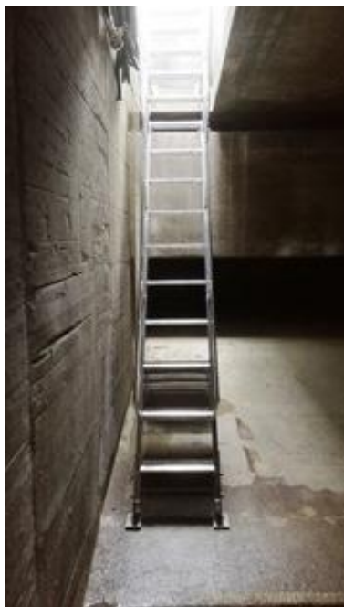
Abbildung 9: Neuer SUVA-konformer Einstieg RB Luxburg
