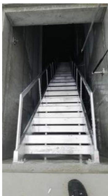
Abbildung 6: Neuer SUVA-konformer Einstieg RB Luxburg
