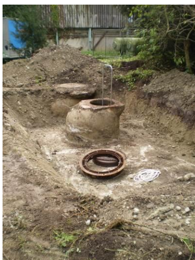
Abbildung 11: Alter Einstieg RB Verzinkerei
