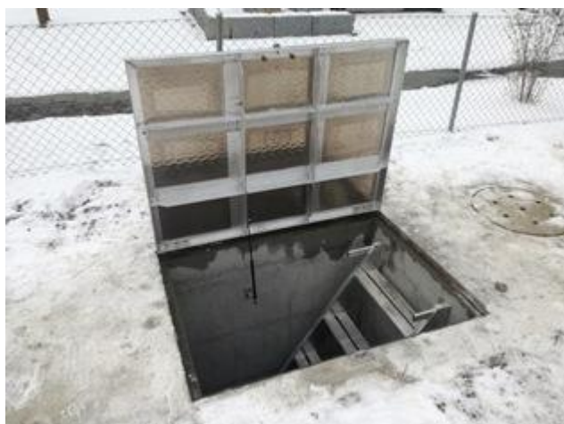
Abbildung 7: Neue Einstiegsöffnung ins RB Luxburg
