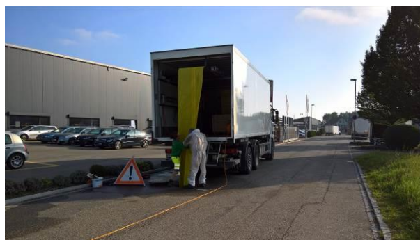
Abbildung 1: Einbau Liner Aachstrasse
