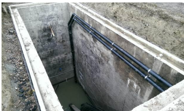
Abbildung 5: Schneckensumpf abgedeckt für Sanierung
