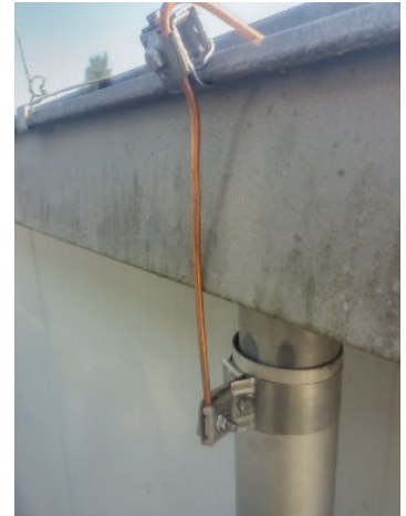
Abbildung Dachwasser Erdung
