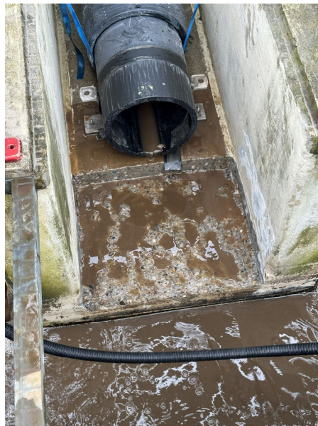
Abbildung Kanalerweiterung für MID
