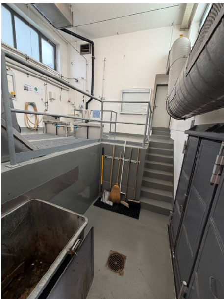
Abbildung Rechengebäude Neubeschichtung
